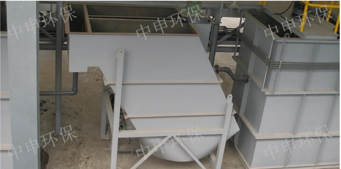
混凝就是向水体中投加一些药剂,通过凝聚剂水解产物压缩胶体颗粒的扩散层,达到胶粒脱稳而相互凝结;或者通过凝聚剂的水解和缩聚反应形成的高聚物的强烈吸附架桥作用,使胶粒被吸附粘结。混凝沉淀处理过程包括凝聚和絮凝两个阶段。在凝聚阶段水中的胶体双电层被压缩失去稳定而形成较小的微粒;在絮凝阶段这些微粒互相凝聚形成大颗粒絮凝体,这些絮凝体在一定的沉淀条件下可以从水中分离去除。斜管沉淀池是根据“浅层沉淀”理论,在沉淀池放置与水平面成一定倾角的斜板或蜂窝斜管组件,以提高沉淀效率的一种沉淀池。在沉降区域设置许多密集的斜管或斜板,使水中悬浮杂质在斜板或斜管中进行沉淀,水沿斜板或斜管上升流动,分离出的泥渣在重力作用下沿着斜板向下滑至池底,再集中排出。这种池子可以提高沉淀效率50%-60%,在同一面积上可提高处理能力3-5倍。按水流与污泥的相对运动方向,斜板沉淀池可分为异向流、同向流和侧向流3种。徐州拦污水利沉淀池厂家二次沉淀池是接纳生化处理的出水,用以沉淀生物悬浮固体获得澄清水的装置。
